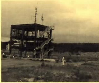
南三陸町防災対策庁舎 2013年6月25日撮影
